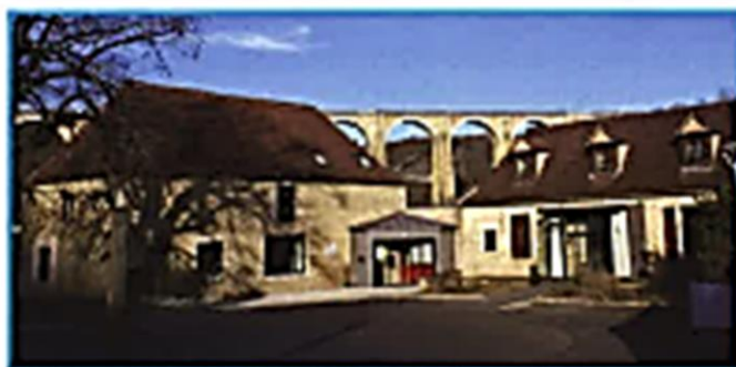
Siège social, vue sur la porte d'entrée. En arrière-plan le viaduc de Bramefond à Souillac
